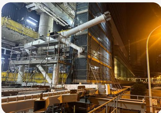
可供制造和装配的设计（DfMA）方针是指先在场外预制大型建筑组件，再运到工地组装。金钟道天桥二期项目的钢结构现正采用这种建筑法，简化兴建天桥所需约350公吨钢材的钢组件制造、运送和架设过程。天桥共分九段，每段再细分六个主要组件，每个重量最高达12公吨。这些钢材在中国内地预制，由拖车运往香港金钟地盘，安全高效地在现场组装，尽量减少
