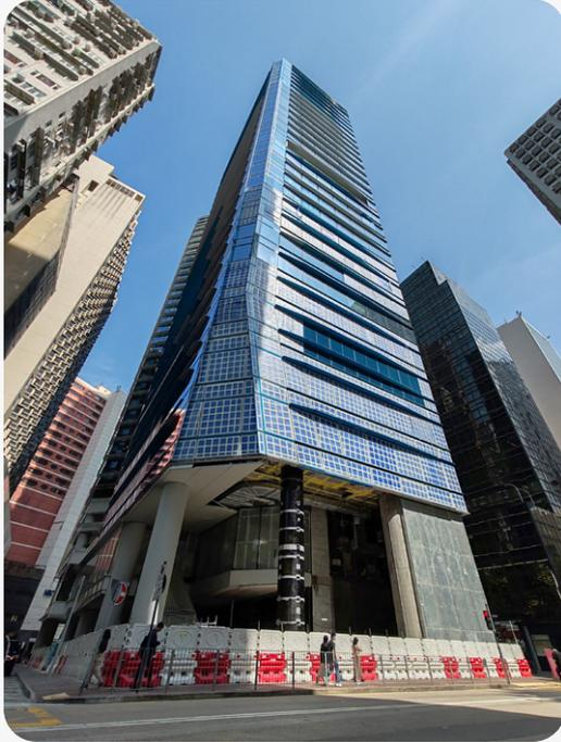
2023年，太古广场六座建筑工程继续达到我们进取的可持续发展目标，上盖建筑全面使用获得建造业议会绿色产品认证铂金级认证的混凝土。此外，在项目使用约6,600公吨的钢筋中，65%为含有超过60%回收物料的环保钢筋。于建筑期间，工地接通公共电网供电，场内不需使用发电机，将噪音和空气污染降至最低，同时减少工地的碳排放。
